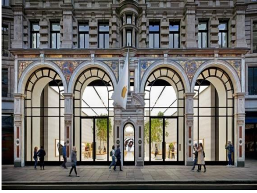
٣-٥-٢ الانموذج الثاني: الفضاء الداخلي لمعرض أبل في شارع ريجنت ( Apple Regent Street ):-
